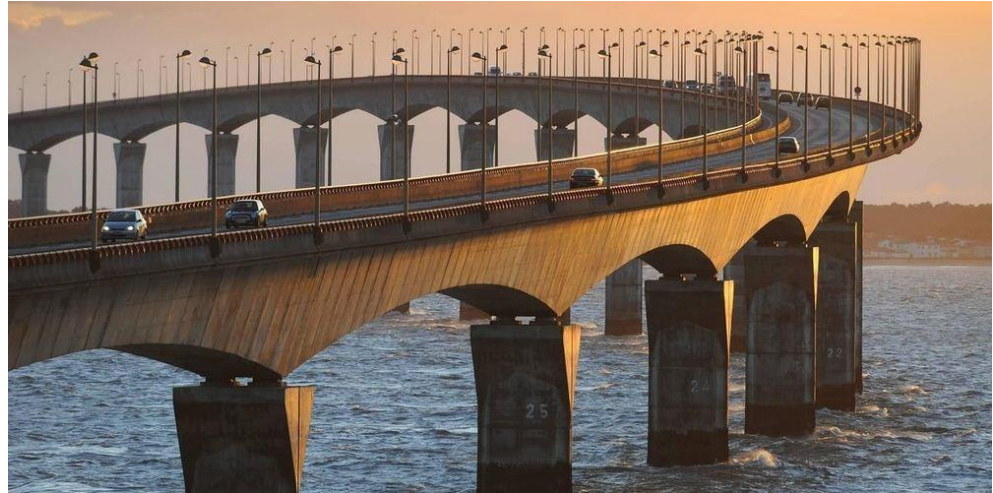
Pont de l'Île de Ré
