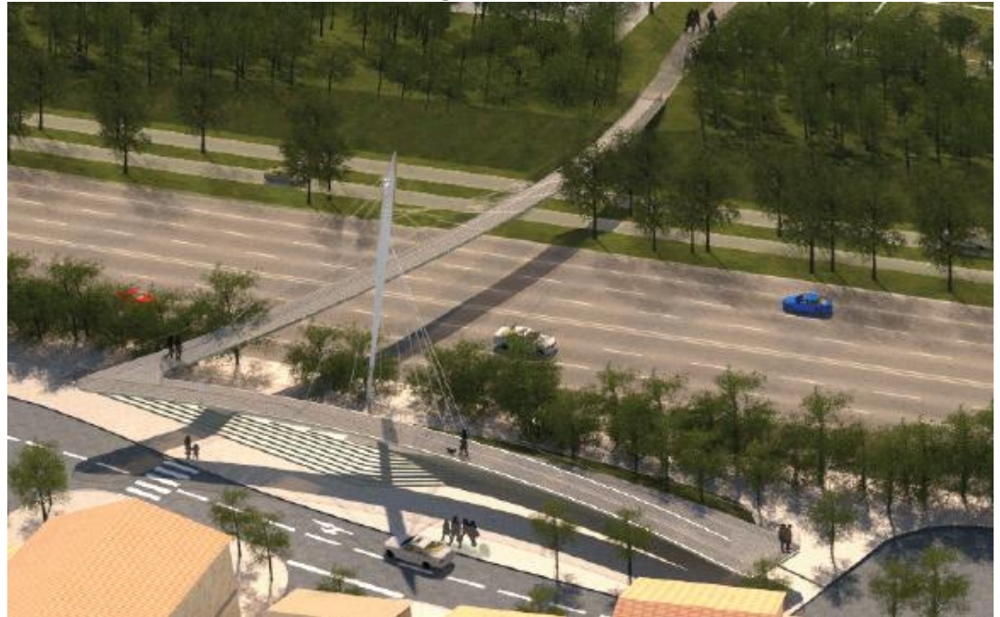
Vue générale de la passerelle
